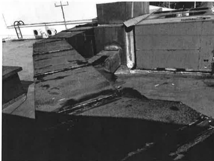
Ductos de aire acondicionado dañados y en mal estado
