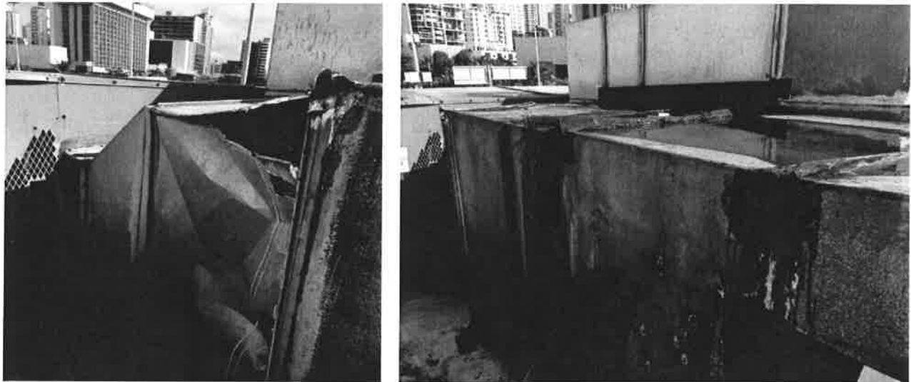
Ductos de aire acondicionado dañados y en mal estado
