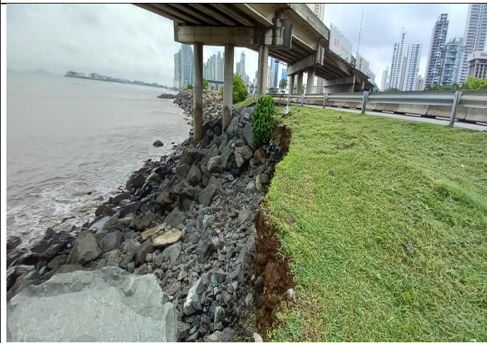
Foto N°1: Vista del primer punto de socavación.
