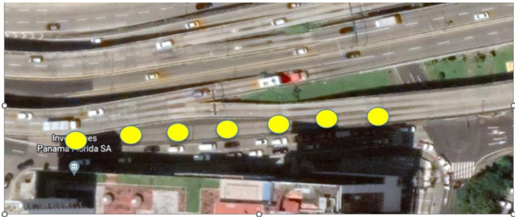
Ilustración 1: Localización de zonas con acero expuesto.
