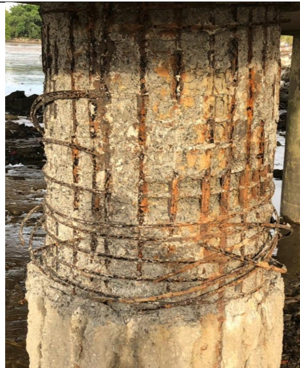
Pila luego de hidrodemolición
