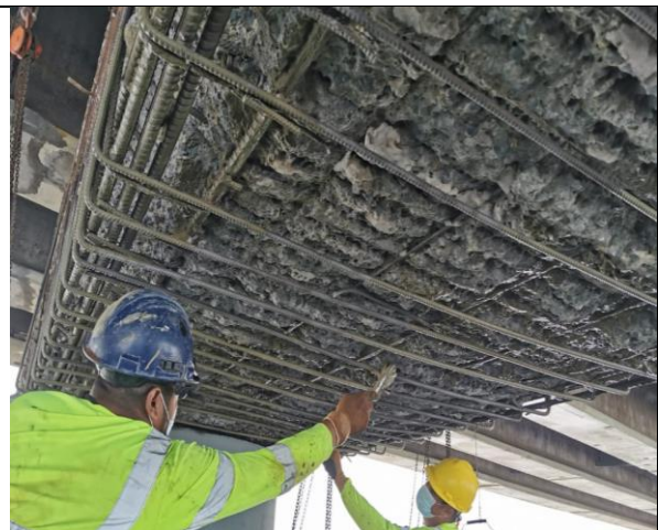
Fondo de viga cabecera luego de hidrodemolición, reposición de aceros y aplicación de pasivador
