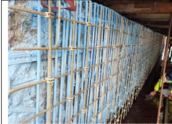
Cara lateral luego de hidrodemolición, reposición de acero, aplicación de pasivador y colocación de armadura de GFRP
