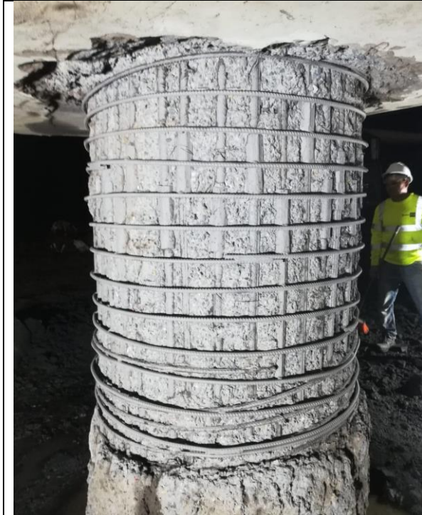
Pila luego de reposición de acero y aplicación de tratamiento anti-corrosivo
