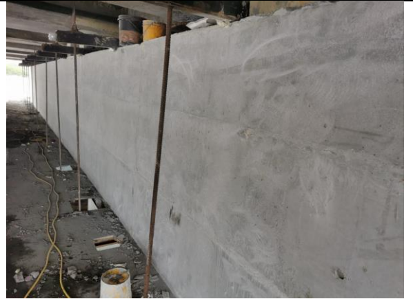
Cara lateral luego de colocación de recrido con concreto autocompactante
