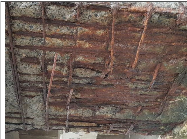
Fondo de viga cabecera antes de intervención
