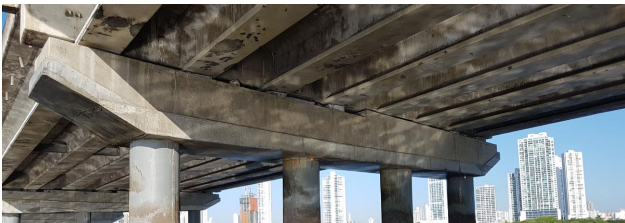
Viga Cabecera terminada con tratamiento Alternativa 2
