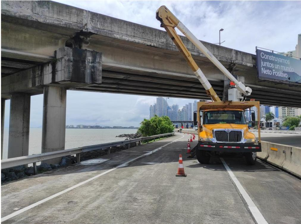
Foto 27.- Vista general trabajos de inspección con camión cesta
