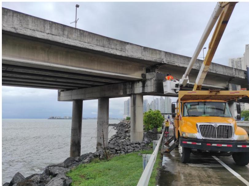
Foto 08.- Vista medios de elevación para inspección de la estructura.
