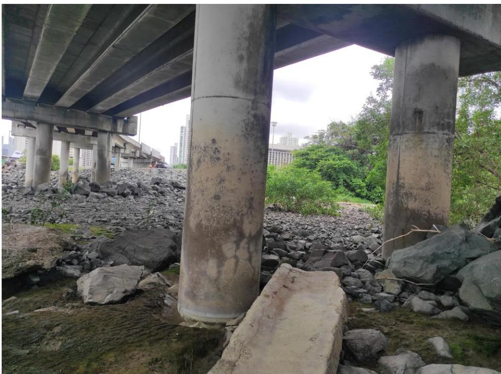
Foto 06.- Vista detalle pilas en escollera debajo de viga de asiento B
