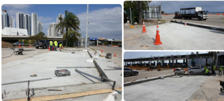
Nuevos Estacionamientos – Edificio Vía Israel
