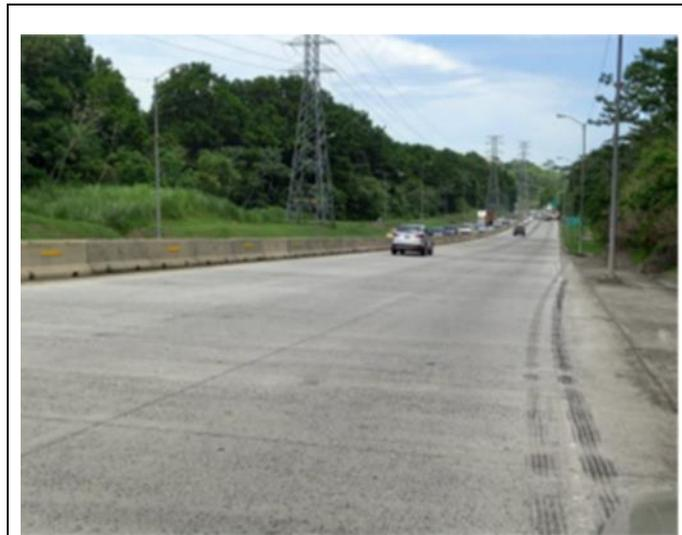
Foto # 1. Reflejo de junta entre losa de aproche y del puente.
