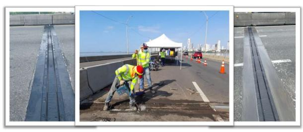
sistema original conformado por perfiles metálicos por un sistema modular de alta flexibilidad, lo cual nos ayuda a garantizar la seguridad operativa y del tráfico bajo cualquier condición.
