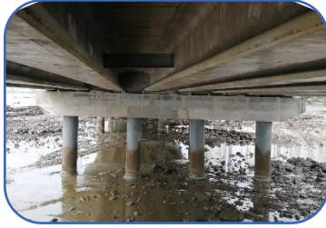
Condición final de las pilas
