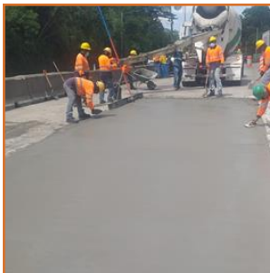
3. Acabado final sobre la losa de pavimento reparada
