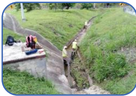
Limpieza de contracunetas
