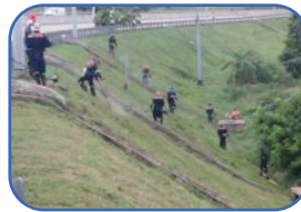
Mantenimiento de derecho de vía
