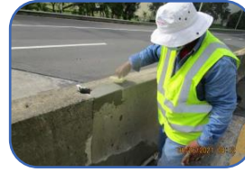
Resane de barreras central o barreras Jerseys
