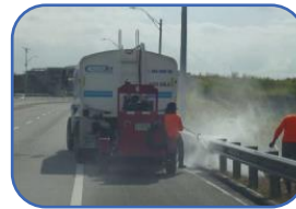
Limpieza mecánica de barreras guardavías
