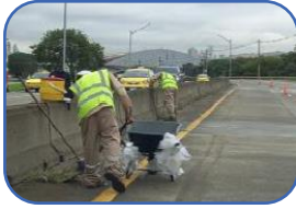
Limpieza de barrera central (Barreras Jerseys)
