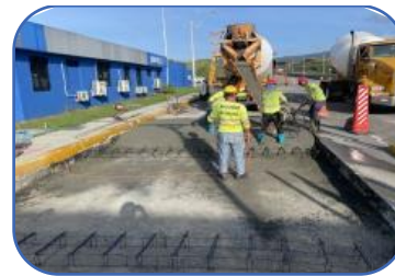
Adecuación de estacionamientos (Brisas del Golf)
