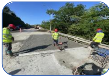
Reposición de losas de concreto
