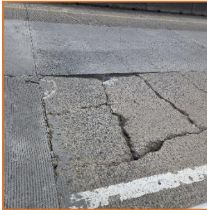
1. Condición existente de la calzada (losa de concreto)
