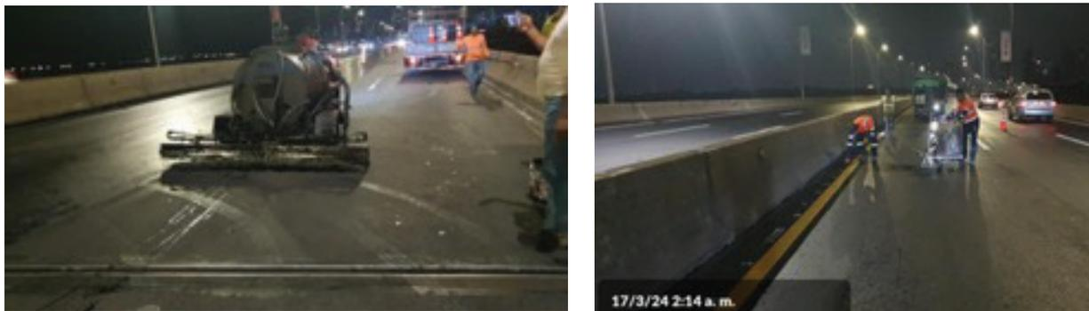
El alcance de estos trabajos incluía la colocación del rejuvenecedor, línea blanca continua, línea amarilla continua, línea blanca discontinua, desbaste de pintura y suministro e instalación de vialetas.
