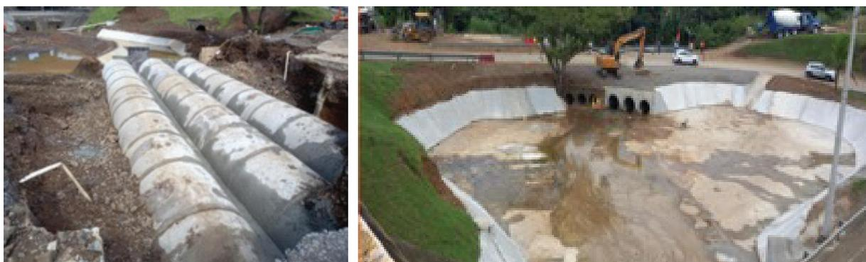
Para este proyecto se instalaron 3 tuberías de 1.50m y 22m de longitud, atravesando la rampa de Camino de Cruces hacia Brisas del Golf; se construyó un canal hidráulico y cuatro cabezales con zampeado de concreto en las entradas y salidas y se realizó la construcción de una noria.
