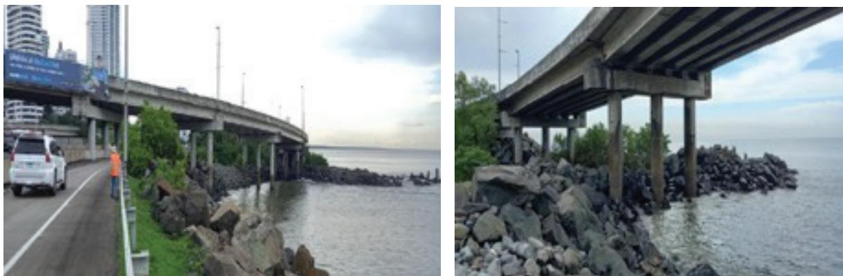
Se realizaron los estudios, pruebas y ensayos: se diseñó y se estableció la metodología para la rehabilitación y se procedió con la rehabilitación de las pilas de la Rampa 31; de las vigas cabeceras, de las vigas trabes, de las prelasas y la rehabilitación de los diafragmas.
