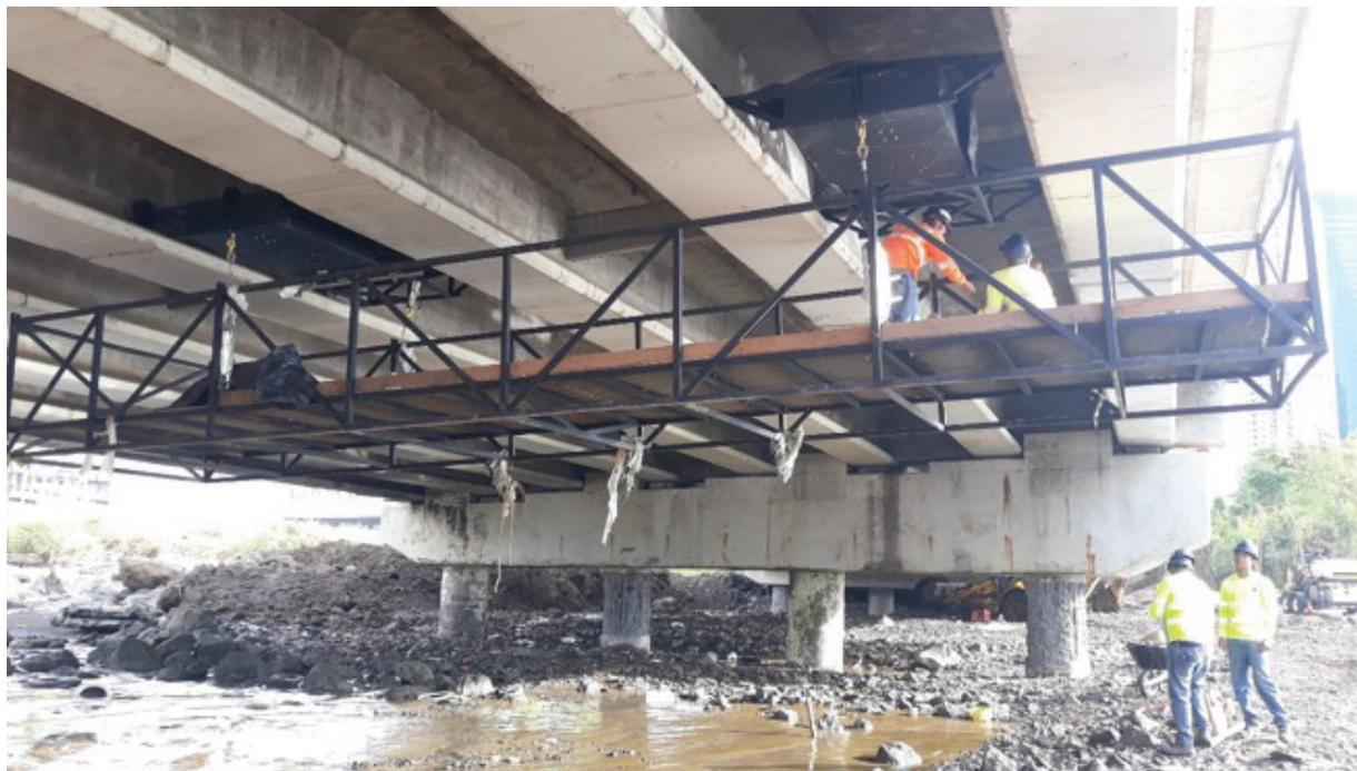
Instalación de elementos temporales de contención, medios auxiliares para las reparaciones, trabajos de rehabilitación estructural; se repararon la totalidad de las pilas, vigas cabeceras, vigas y demás elementos que componen la subestructura.
