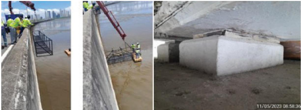
Inclúan el diseño y reconstrucción de los 132 pedestales de concreto, suministro de 132 almohadillas de neopreno, limpieza y pintura de 36 platos de acero y la reparación de dos travesaños con recrecido reforzado en la zona de apoyo de la viga cabecera del eje 19, además de trabajos en los platos de los pedestales.
