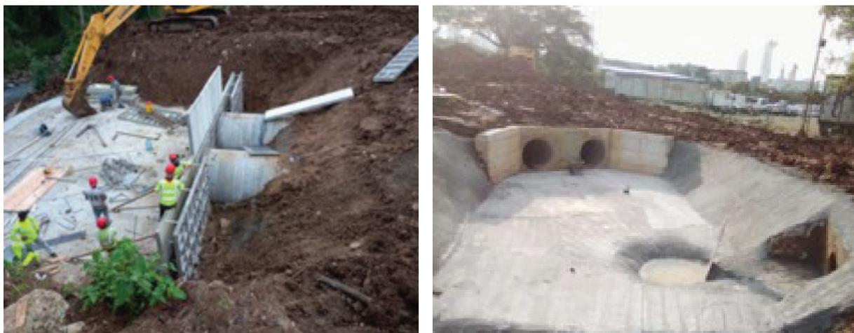
El alcance de este proyecto incluía la instalación de tubería doble de hasta 112.00 metros lineales, excavación, relleno, construcción de una cámara pluvial, construcción de dos cabezales y zampeado.
