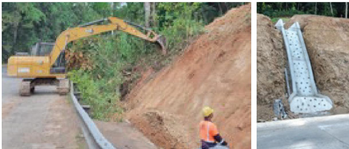
Los trabajos de adecuación del talud incluían suministro de material, mano de obra, equipos, estudio de impacto ambiental, desmonte, poda y tala de árboles, replanteo topográfico, movimiento de tierra corte y relleno, construcción de cunetas y derramaderos, hidrosiembra.
