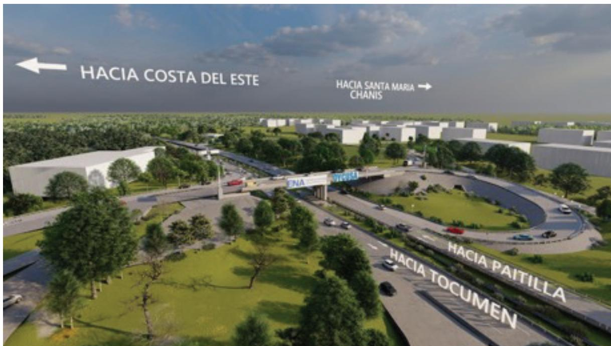
Con una inversión de B/.20,803,669, este proyecto consiste en la construcción de los ramales de salidas y accesos a Costa del Este desde la calzada del Corredor Sur, que conecta con el viaducto del tramo marino. En el diseño preliminar se prevén dos rampas, una de acceso al Corredor Sur con conexión al viaducto del tramo marino y la otra rampa de salida que conecta con la Ave. Paseo del Mar en la zona de Costa del Este.
