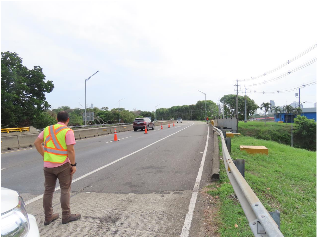
Ilustración 1 - Vista General de PSV Martín Sosa
