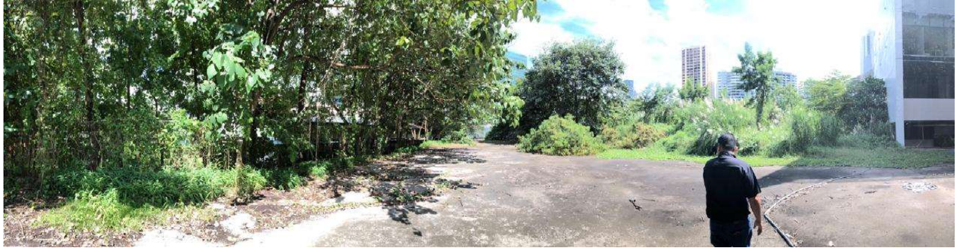
Aspecto panorámico de parte superior de Corredor Sur, en parte superior de Túnel Las Esclavas. Se aprecia el follaje excesivo, riesgo de caída de árboles, junto a deterioro y vandalización de cercado.
