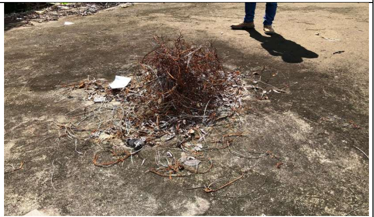
Mal manejo de desechos de trabajos, por parte de JC Decaux, en la parte superior de túnel.
