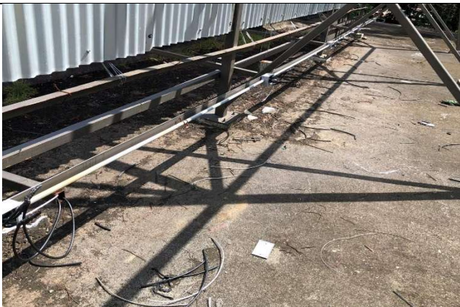
Sección inicial de parte superior de túnel. Se aprecia la valla publicitaria y bajo ella, restos de trabajos por parte de JC Decaux.
