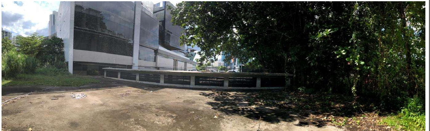
Aspecto panorámico de parte superior de Corredor Sur, en parte superior de Túnel Las Esclavas. Se aprecia el follaje excesivo, riesgo de caída de árboles, junto a deterioro y vandalización de cercado.
