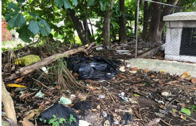
Depósito informal de basura dentro de servidumbre, cercana a ventilación de túnel.
