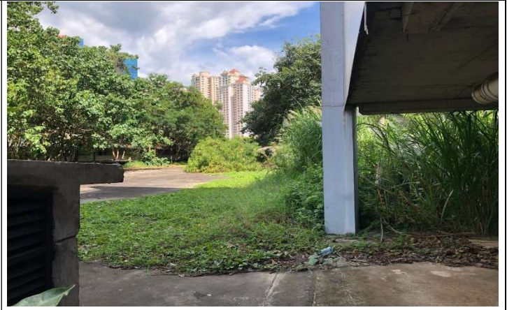
Aspecto de acceso a parte superior de túnel. Se aprecia el follaje excesivo junto a la falta de medidas para protección de acceso.
