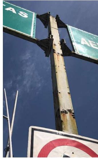
Se presenta evidencia de oxidación a lo largo de los elementos verticales y horizontales metálicos de la bandera.
