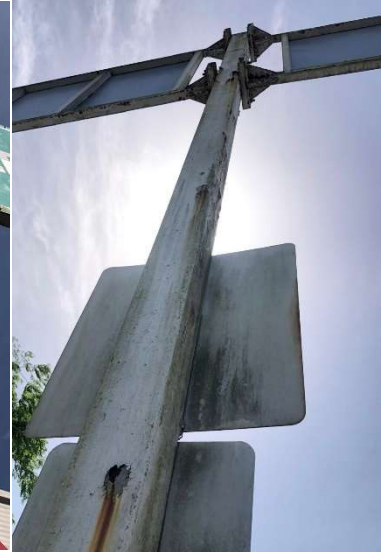
Se presenta evidencia de oxidación a lo largo de los elementos verticales y horizontales metálicos de la bandera.
