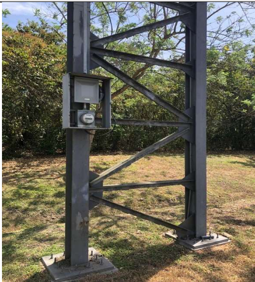
Se evidencia el estado del pórtico, el cual solo necesita limpieza.
