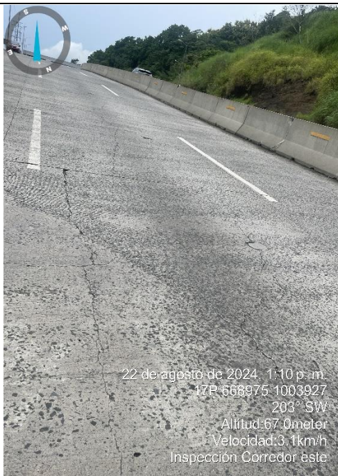
Foto N°11: Foto N°7: Brisas del Golf @ Brisas Norte
