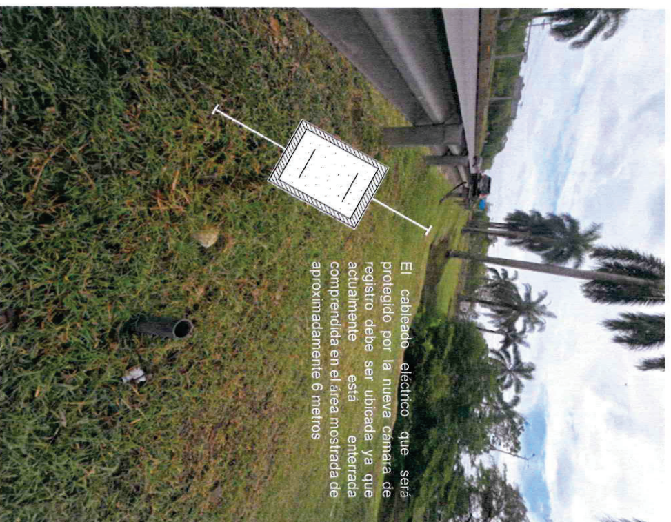
Imagen12. área aproximada para la instalación de cámara de registro4.
