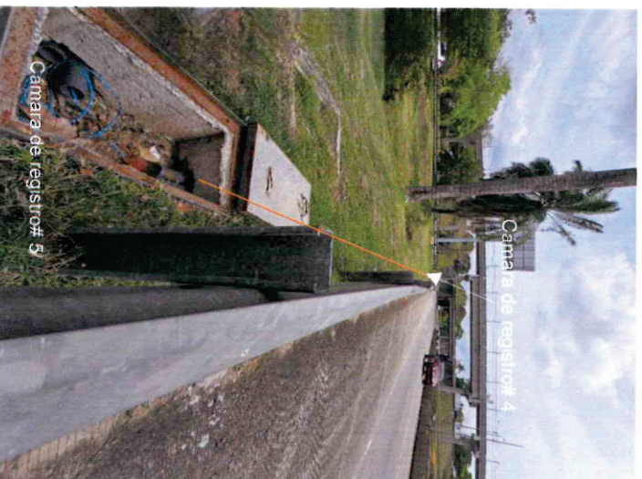
Imagen14. línea naranja con ruta posible de vigaducto7 desde cámara de registro4 que debe ser fabricada e instalada hasta cámara de registro5.
