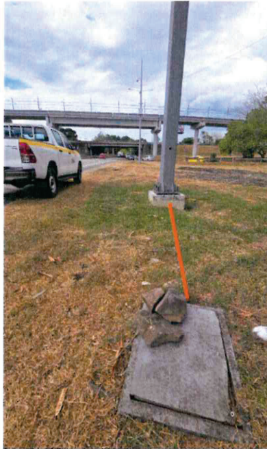
Imagen6. Línea naranja con posible ruta de vigaducto4 desde la cámara de registro2 hasta poste donde está ubicado el PLATE 06.
