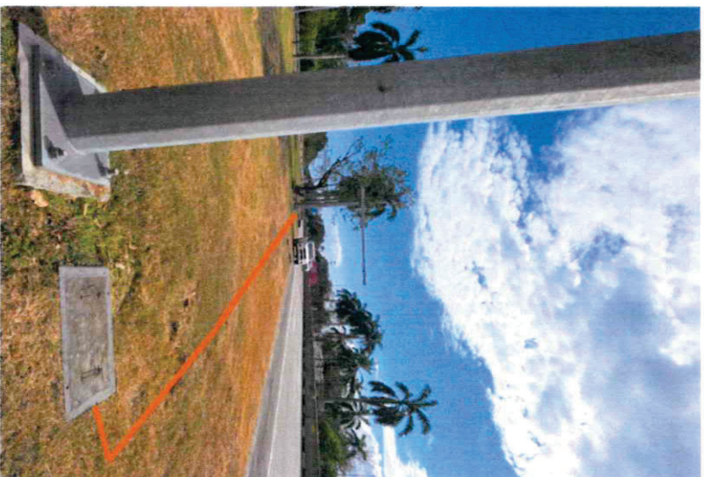
Imagen8. línea naranja, posible ruta del vigaductos desde cámara de registro2 hasta cámara de registro3.
