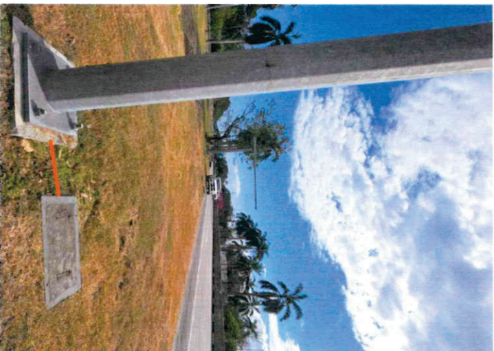
Imagen9. línea naranja con posible ruta de viga ducto 6 desde cámara de registro hasta poste donde está ubicado la DA130.
