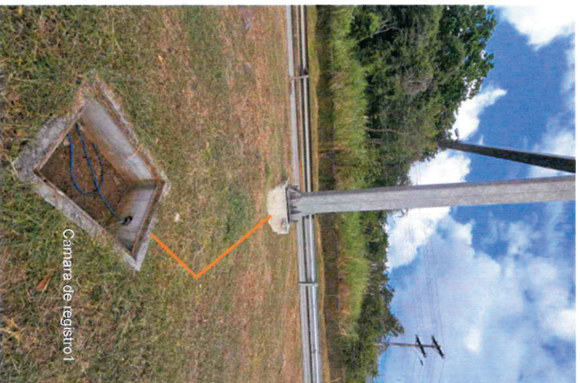
Imagen 1 . Línea naranja con la posible ruta del vigaducto desde el poste de la PLATE 10 hasta cámara de registro 1 .
