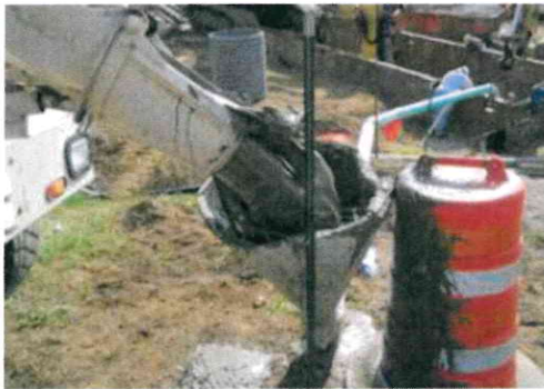
Ilustración 6. Proceso de llenado de tuberías con lechada.
