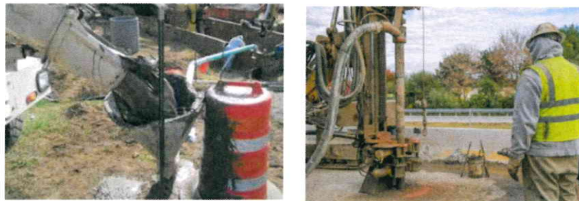
Ilustración 3. Proceso de llenado de tuberías con lechada.
