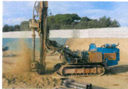
Ilustración 2. Proceso de perforación de chimeneas.
