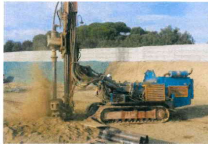
Ilustración 5. Proceso de perforación de chimeneas.
