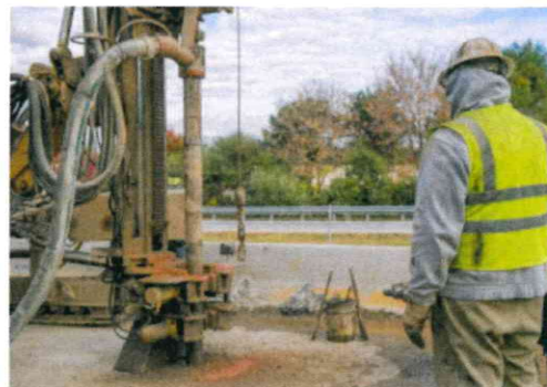
Ilustración 6. Proceso de llenado de tuberías con lechada.
