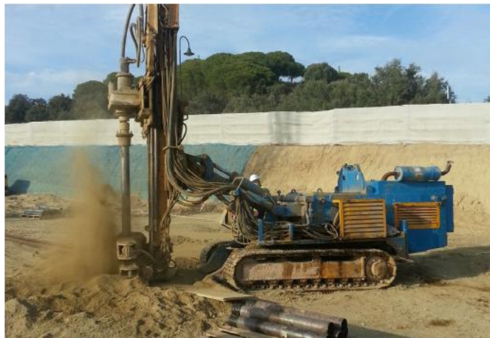
Ilustración 5. Proceso de perforación de chimeneas.
