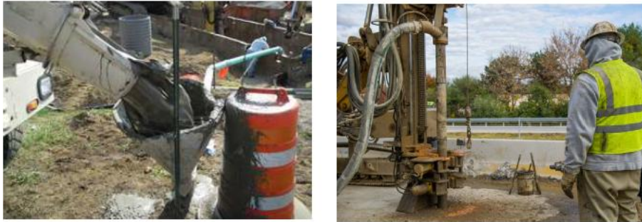
Ilustración 6. Proceso de llenado de tuberías con lechada.
