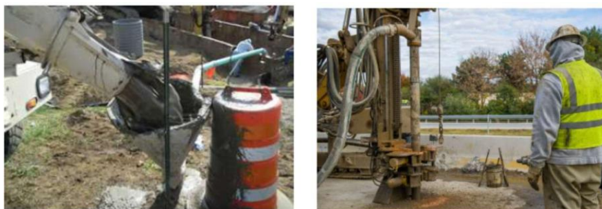
Ilustración 6. Proceso de llenado de tuberías con lechada.
