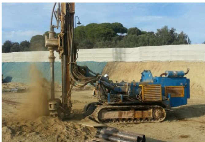
Ilustración 5. Proceso de perforación de chimeneas.
