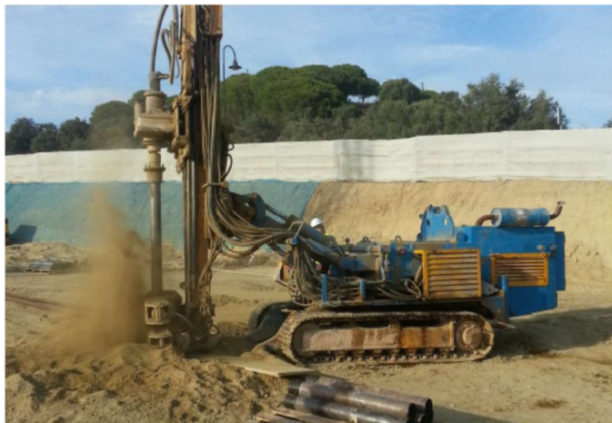
Ilustración 5. Proceso de perforación de chimeneas.
