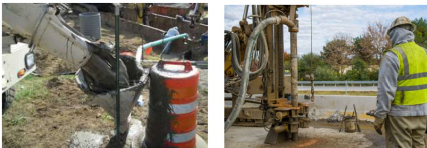
Ilustración 6. Proceso de llenado de tuberías con lechada.
